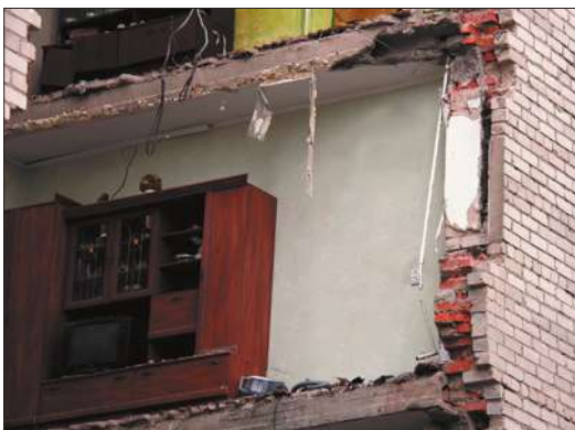
Нарушение прочности, устойчивости несущих конструкций здания, при котором может произойти их разрушение.
