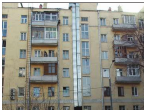
Устройство на фасаде многоквартирного дома вентиляционных коробов.
